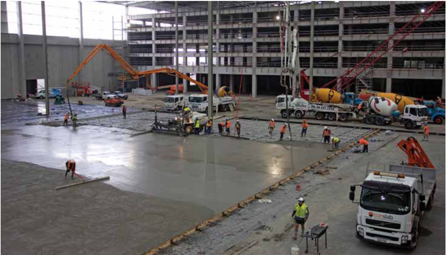
Fig. 8—Large bay post-tensioned floor pour at JPL.
