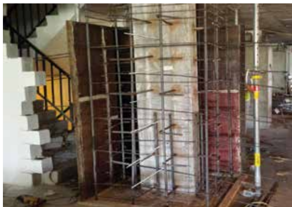
Fig. 8—Column enlargement.
