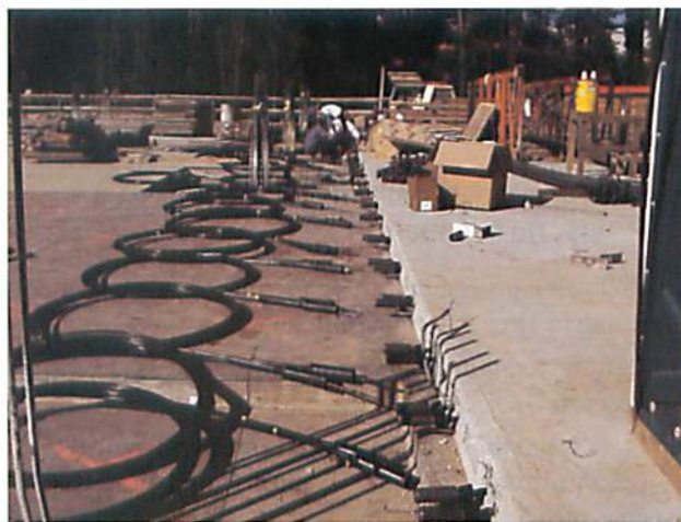
Fig. 5 – Coupling Tendons in a Continuation Slab Pour
